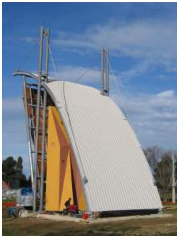
Exemple de ce genre de structure pendant les travaux. Couverture en tôle.
