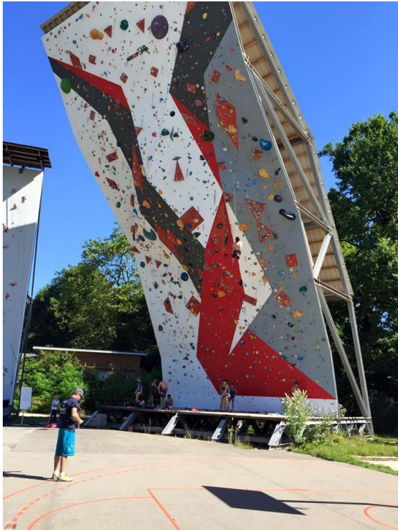
Mur de difficulté de 16 mètres
